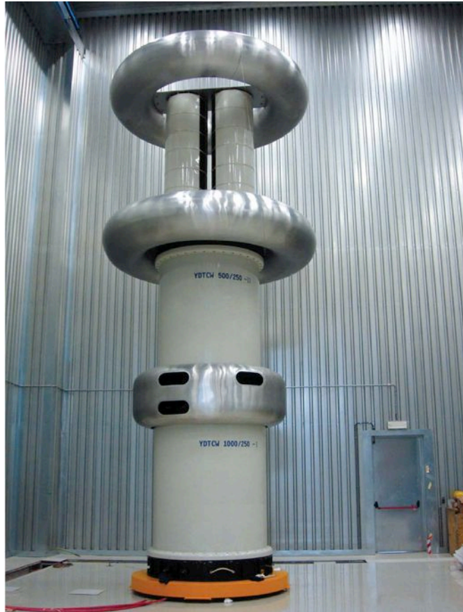
Система испытания с трансформатором 1500 кВА / 500 кВ SIEMENS TRANSFORMERS SPA
